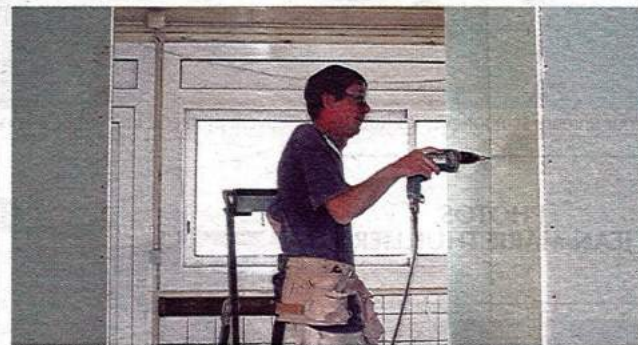
À l'école Jean-Moulin, des travaux sont réalisés dans la cuisine
